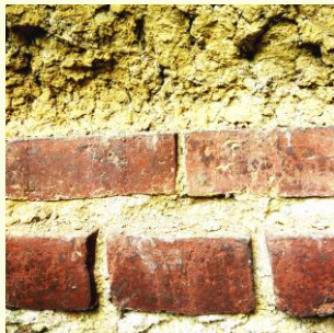
Kombinierte Ziegel-Lehmbauweise
