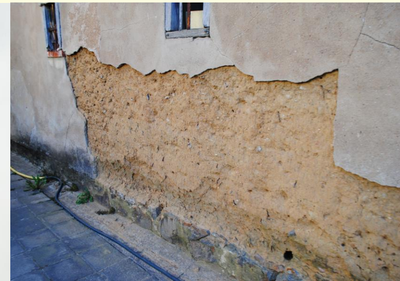
Auch heute noch finden sich oftmals Lehmmauern unter dem Putz
