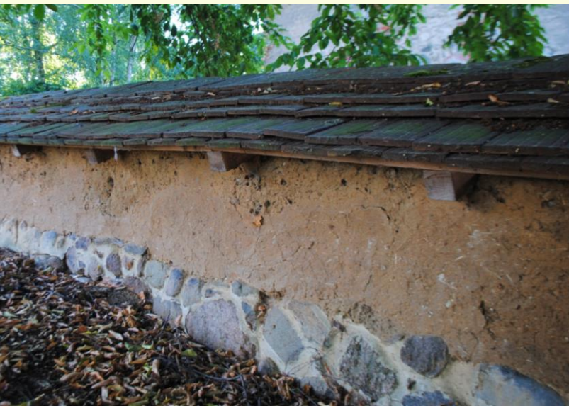
Alte Lehmmauer in Sehlis
