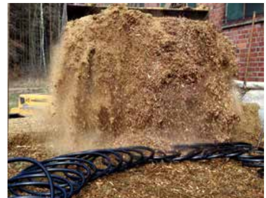
Meileraufbau: auf PE-Rohrschlangen wird Häckselgut verteilt (Foto: Wiesenmeiler)
